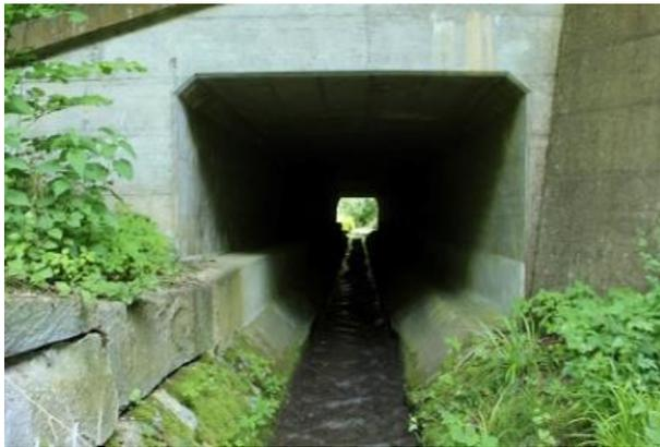
Zu diesem Zweck wird der Zivilschutz in regelmässigen Abständen kleine Strömungsbrecher am Fundament verankern. Somit werden den aufwärts wandernden Fischen beruhigte Zonen zum Verweilen geboten, sogenannte «Trittsteine». Diese Lösung verbindet den sehr dicht von Bachforellen besiedelten unteren Bachlauf im Dorfbereich mit dem Abschnitt oberhalb der Umfahrungsstrasse bis in den Wald. Letzterer wird momentan von den
