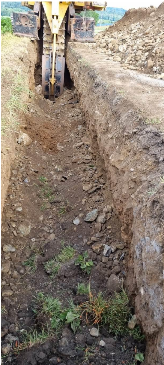
Grabenfräse bei der Arbeit
