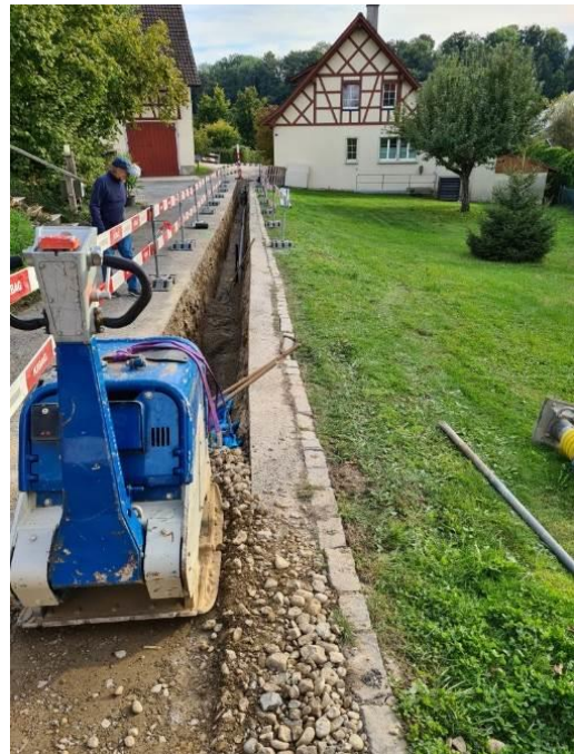
Eindecken der neuen Leitung
