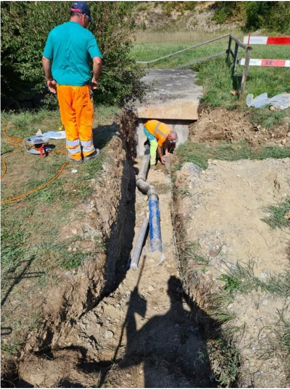
Anschluss an Pumpwerk Seewadel
