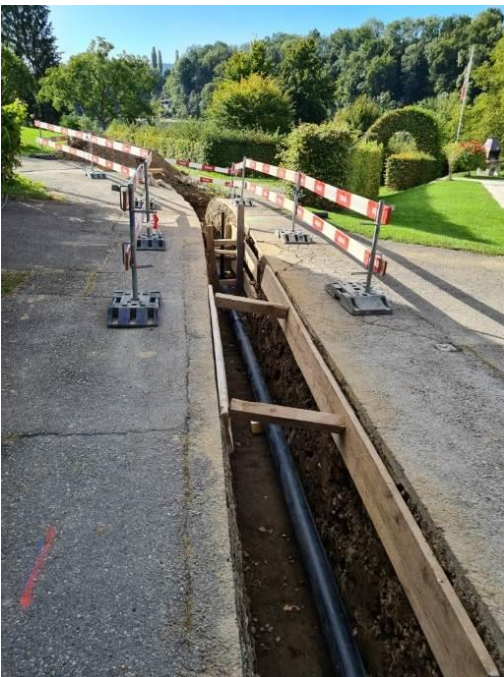
Graben mit der neuen Leitung
