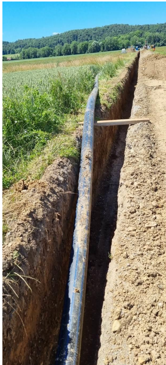
Verlegen der Leitung
