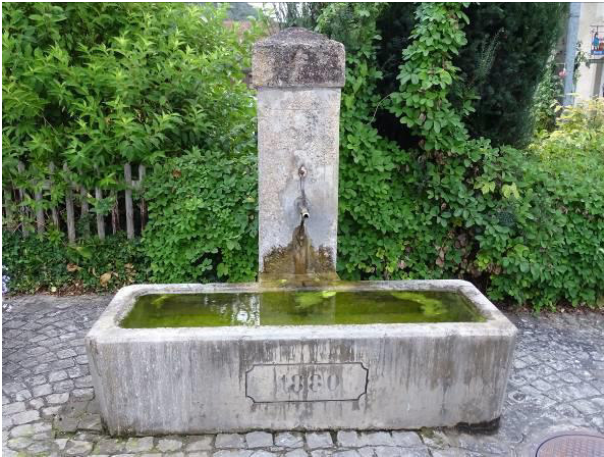
Der Dorfbrunnen: Links vor der Sanierung
