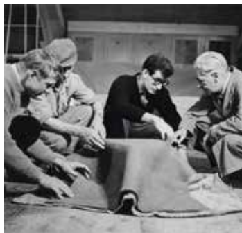
Willy Guhl drapiert in der Eternit AG eine ungebundene Faserzement- platte, 1952 5
