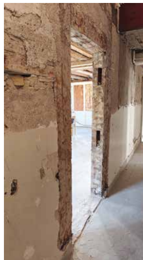
Wanddurchbruch (Foto: Linda Stoll)
