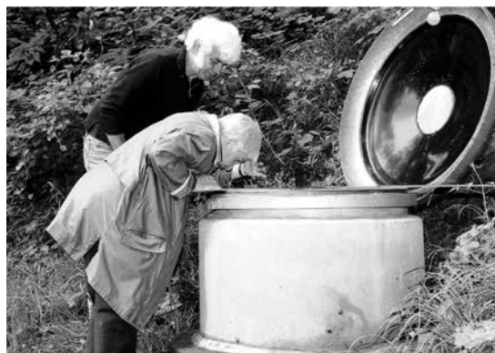
Der damalige Wasserwart Ruedi Schneider mit einer Einwohnerin beim Reservoir am Jubiläumsanlass 100 Jahre Wasserversorgung, 2008.
