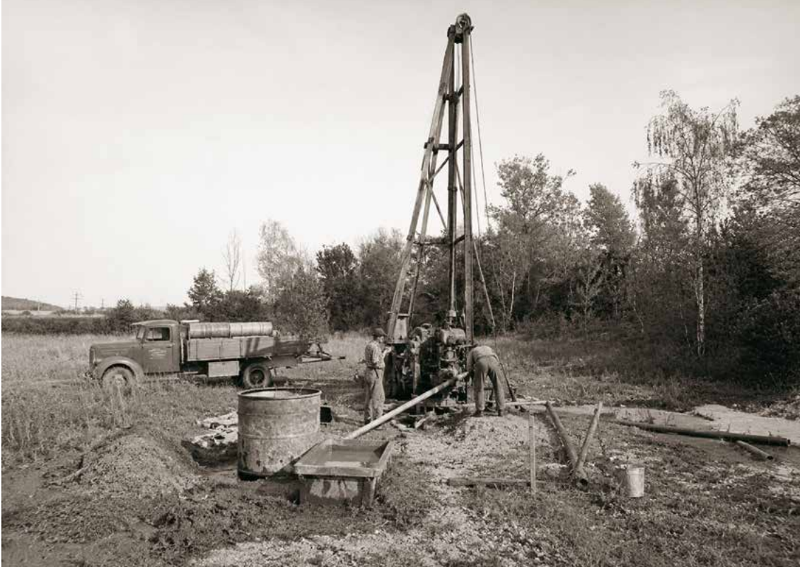
Sondierbohrung im Seewadel 1950.
