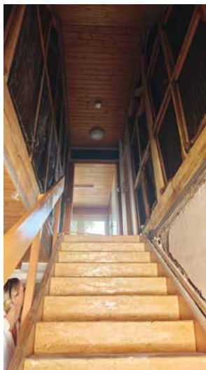
Arbeitseinsatz Treppe OG (Foto: Linda Stoll)
